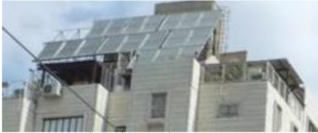
איור 66 : מערכות קולטי שמש גלויות על הבניין
