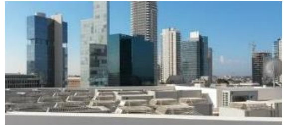
איור 67 : מזגנים מוצנעים על גג הבניין
